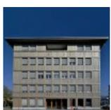
In Einsiedeln ist ein fünfgeschossiges Ärztelhaus in Holzbauweise entstanden. Einziges Bauelement in Nicht-Holzbauweise sind das Treppenhaus in Stahlbetonweise und das Untergeschoss. Das Spezielle an der Errichtung war, dass das Treppenhaus in Filigranelementen parallel zum Holzelementbau geschosswei...
